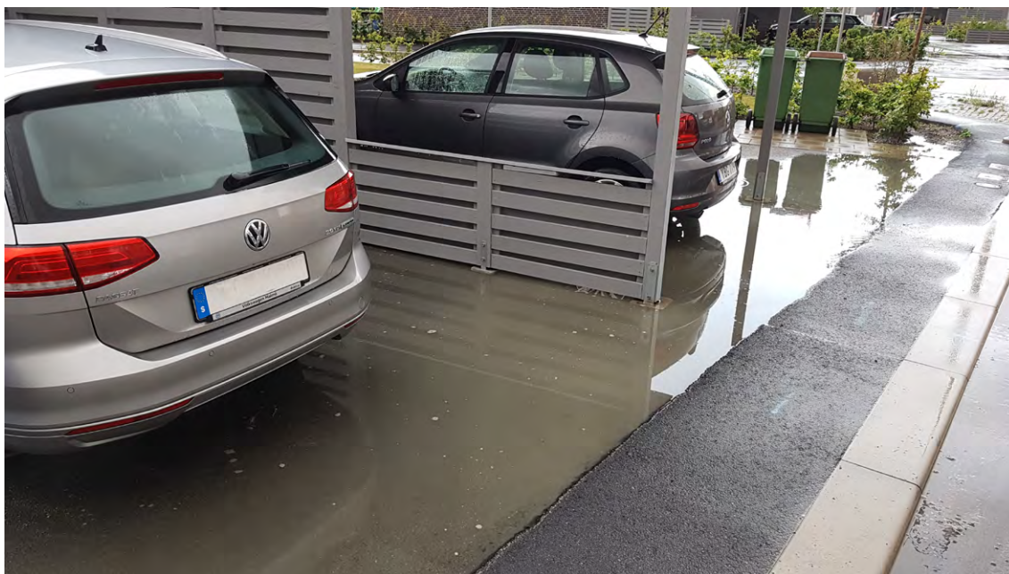
Fig 5. Projekt där samordningen av höjdsättning av allmän plats och kvartersmark brustit mellan kommun och exploatör. Översvämningsproblem vid större regn för ett 50-tal småhus.
